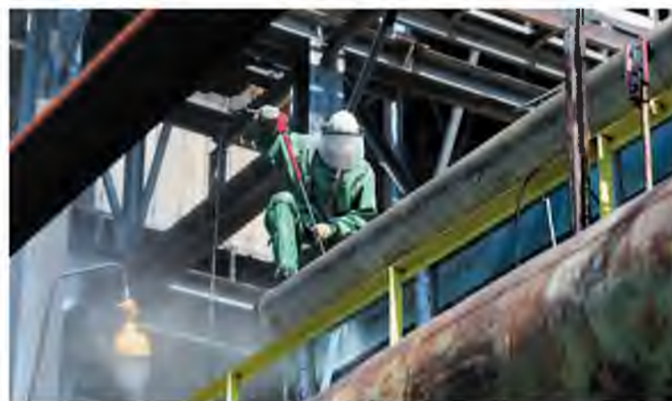
Во время ремонта восстановили антикоррозийную защиту металлоконструкций
