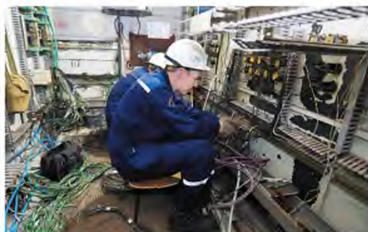
Замена системы управления котлом
